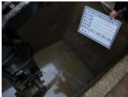
2.(1)防治措施 污泥沉澱措施
