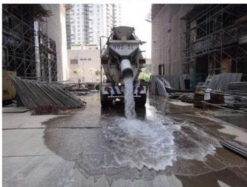
4.(1)防治措施 工地的車行路面灑水噴霧
