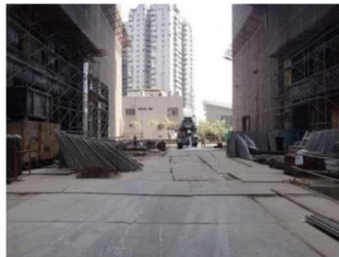
3.(1)防治措施 車行路面鋪設鋼板
