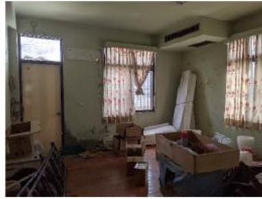
室內現況照片(2021. 9. 30)
