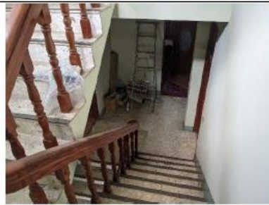
室內現況照片(2021. 9. 30)
